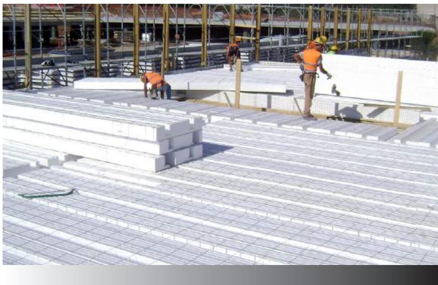
Tale versatilità consente di realizzare solai gettati in opera in edifici di qualunque destinazione d'uso. All'intradosso è già predisposta una rete elettrosaldata di diametro sottile, con funzione di porta intonaco. Il funzionamento strutturale dei Solai Nidyon è del tutto analogo a quello dei tradizionali solai in laterocemento gettati in opera.
